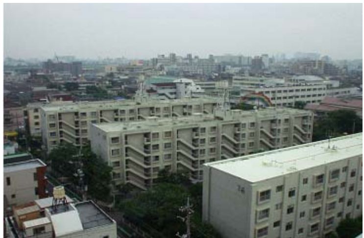
建替え前の萩中住宅
